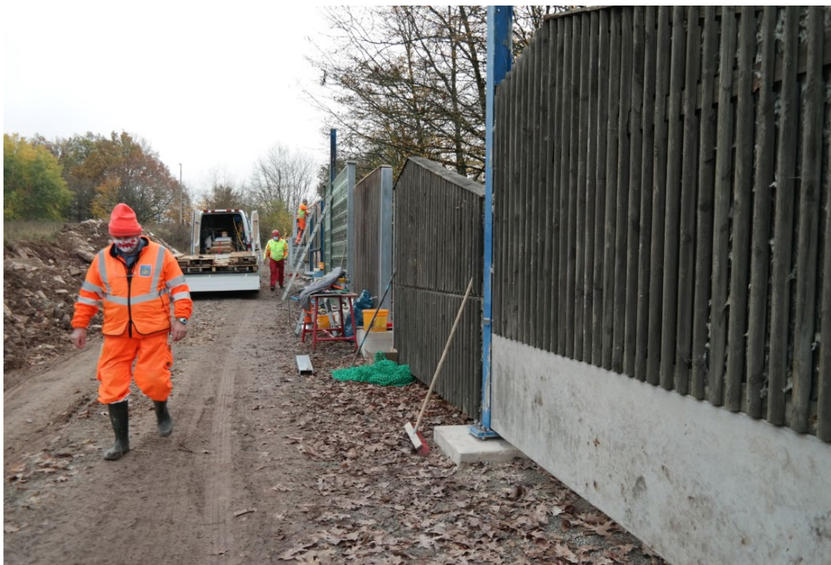
BU: Aufbau der Lärmschutzwände und Stützbauwerke, Foto: Bayerische BauAkademie
