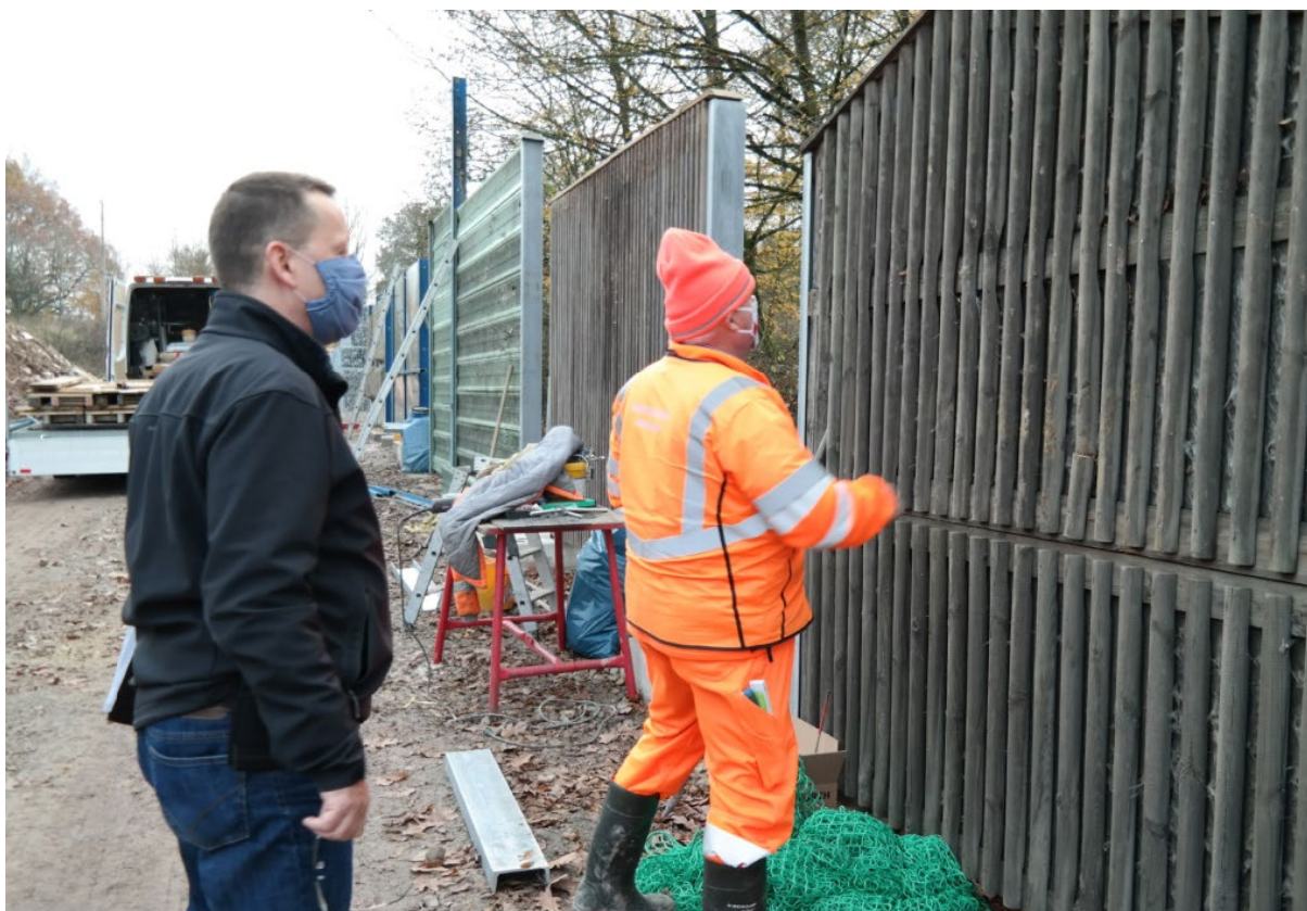
BU: Schadenprüfung Lärmschutzwand, Foto: Bayerische BauAkademie
